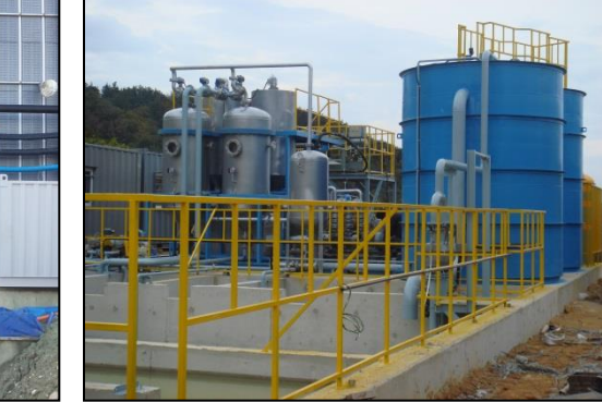
경주-감포 양방향 터널공사 건설현장 ( 100㎡/hr x 2대 )
