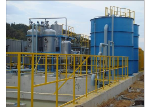
경주-감포 양방향 터널공사 건설현장 ( 100㎡/hr x 2대 )
