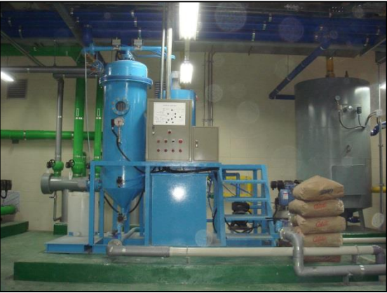
인천계수중학교 빗물 재사용 설치현장
