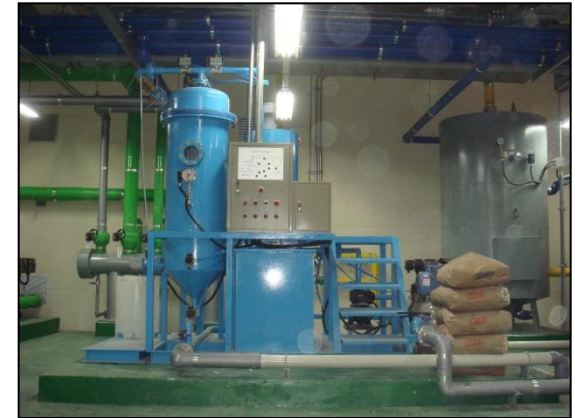
인천계수중학교 빗물 재사용 설치현장
