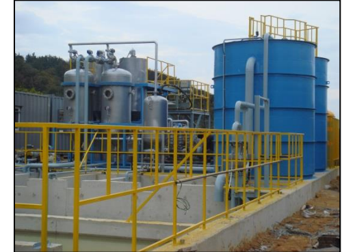
경주-감포 양방향 터널공사 건설현장 ( 100㎡/hr x 2대 )
