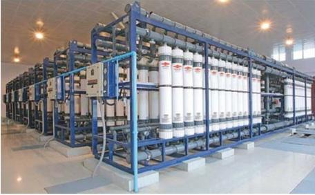
Pressure vessel 속에 중공사(실)을 수천개 에서 수만개 씩 배열시킨 형태로써 분리막 pore size 0.01 ~ 0.001  $\mu\text{m}$  로써 분자량 10,000 ~ 100,000MWCO내의 원충, 세균, 바이러스, 고 분자물질 등을 체걸음 원리에 따라 여과한다
