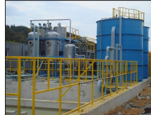
경주-감포 양방향 터널공사 건설현장 ( 100㎡/hr x 2대 )
