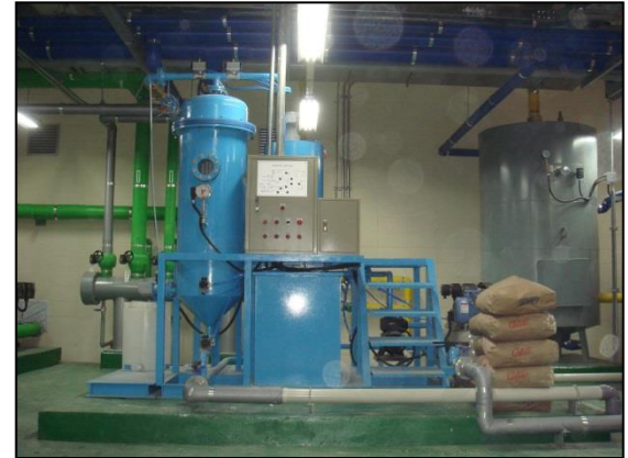
인천계수중학교 빗물 재사용 설치현장
